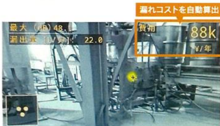
リアルタイムに漏れ量、漏れコストを算出・表示
