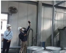
天井に設置されたエア配管の点検
