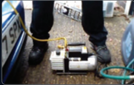
AC装置の冷媒ガス漏れのデジタル画像
