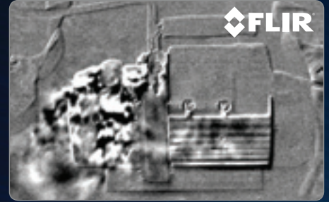
冷媒ガス漏出中のAC装置の高感度モード画像
