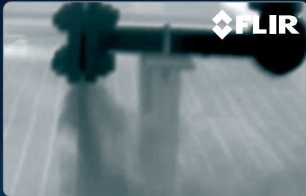
ガスバルブからのメタンの漏出
